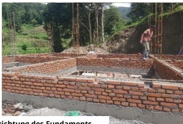
August 2025: Errichtung des Fundaments
